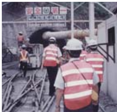
■ 與研究人員一同進入雪山隧道頭城入口施工處
