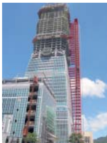
■ 台北101金融大樓採用陳教授發明之鋼骨高韌性梁柱接頭系統
